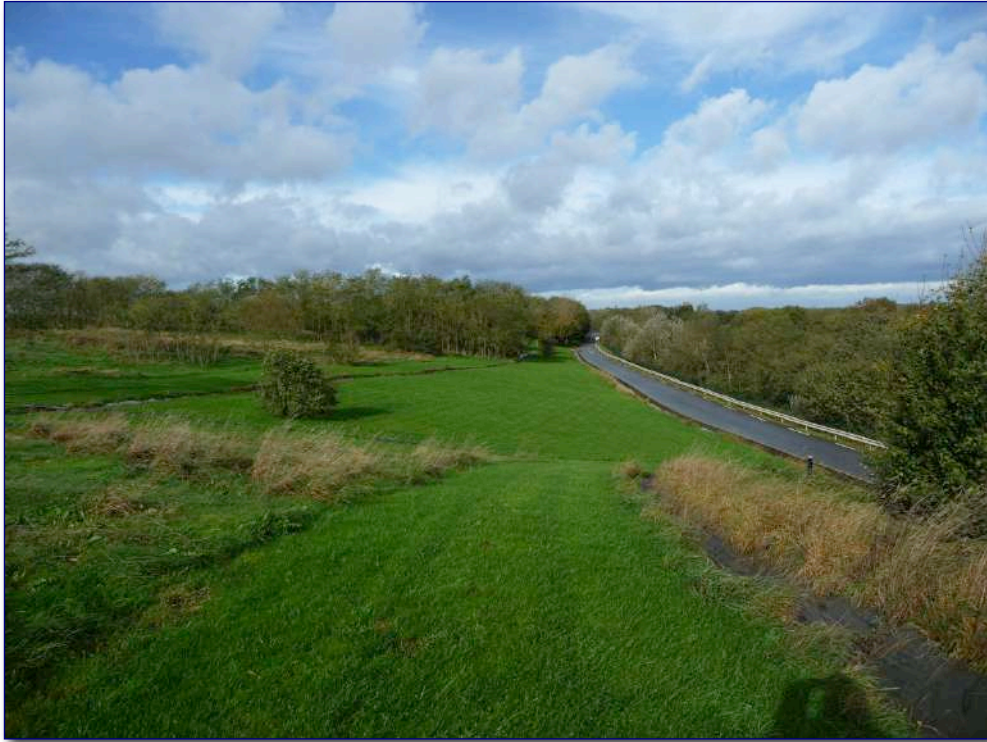
Photo 6 : Zones réaménagées d'une ISDND
