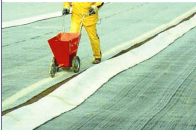
Figure 16 : Exemple de mise en place du GéoSynthétique Bentonitique
