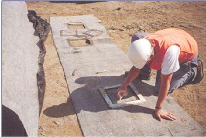
TEST DE CONTROLE IN SITU DE LA QUALITE DU GEOSYNTHETIQUE BENTONITIQUE
