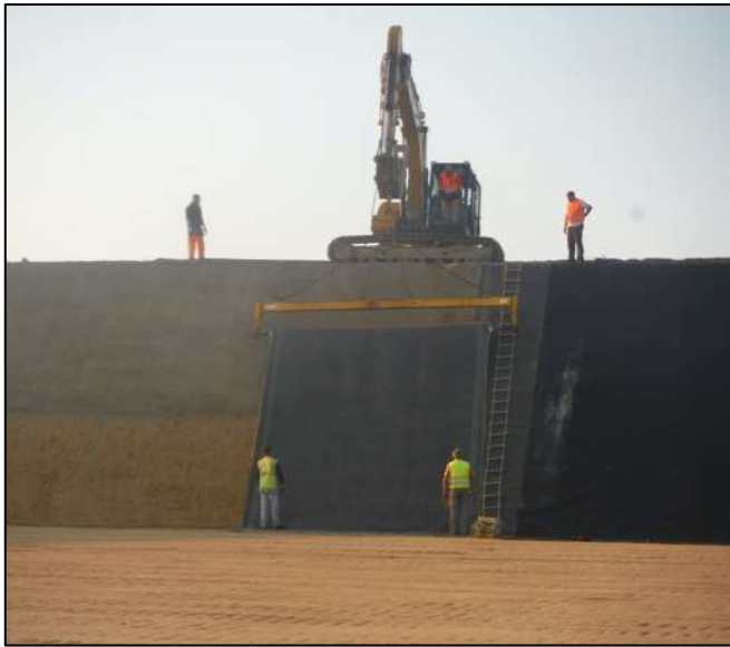
Mise en œuvre du géotextile anti poinçonnant
