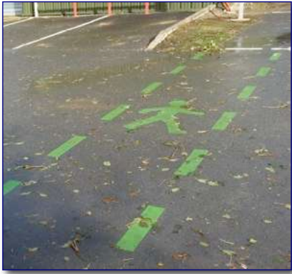
Photo 2 : Marquage au sol pour piéton
