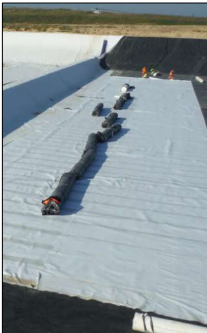
Mise en œuvre du géotextile anti poinçonnant
