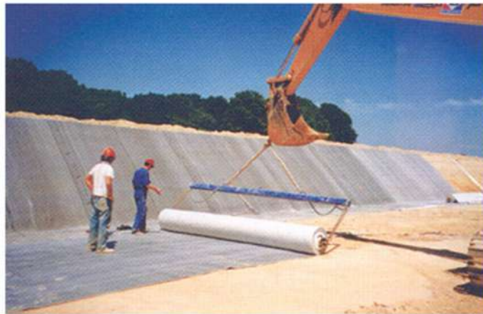
POSE DES ROULEAUX DE GSB EN TUILE
